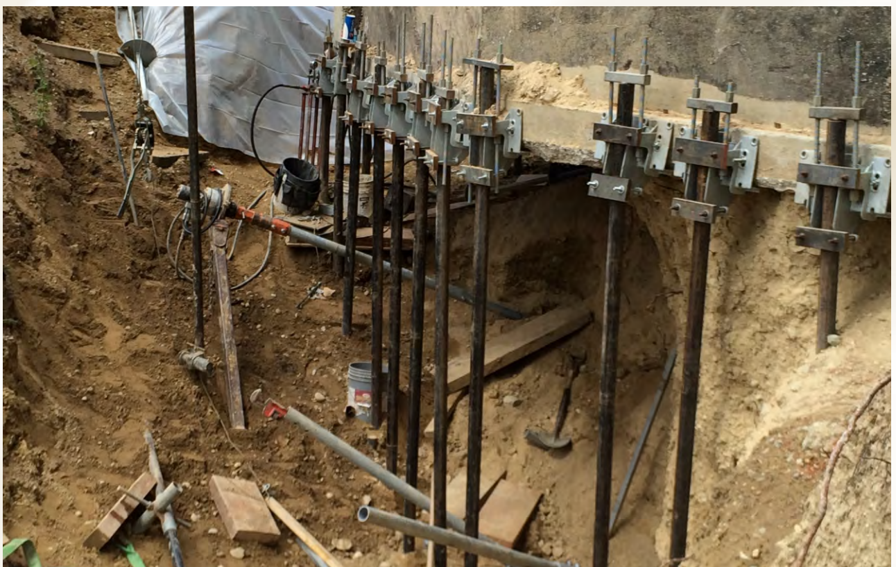
Reforço de fundação e macaqueamento de edificação.
